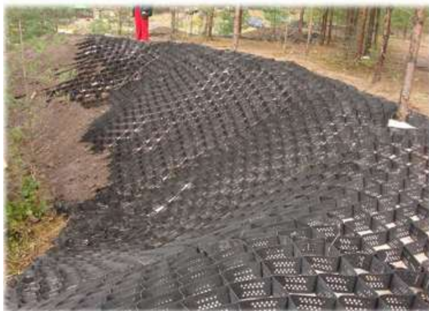
Рис. 1 Применение геосетки для удержания твердых фракций
